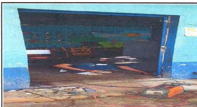
Foto 4: Sustitución de puertas
