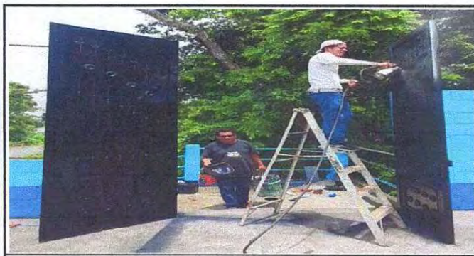
Foto 5: Sustitución de portón de metal
