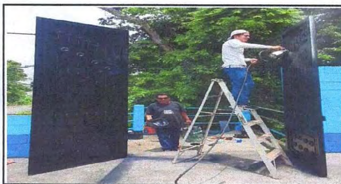
Foto 5: Sustitución de portón de metal
